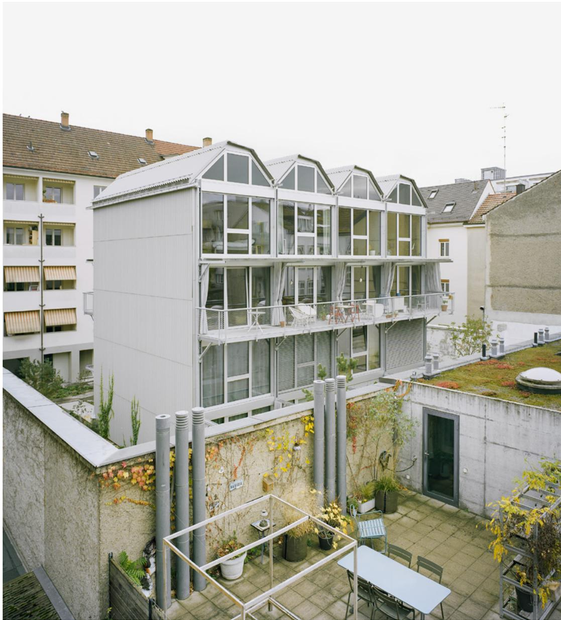
Die vier trapezförmigen Giebel des Hinterhofgebäudes von Felippi Wyssen sind augenfällig. Die Holzkonstruktion ist mit Wellleerit eingedeckt und mit einer PV-Anlage bestückt. Bild: Rasmus Norlander
